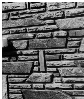
Photo 1 : Appareillage d'un muret de soubassement avec des moellons de schistes taillés manuellement. Joints de 20 mm d'épaisseur environ, au mortier riche de ciment dosé à 500\text{ kg/m}^3 de sable fin
