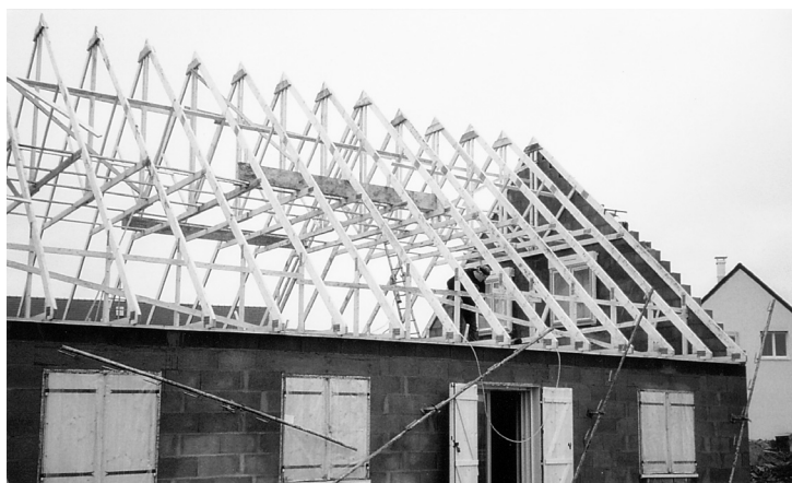
Photo 2 : Fermettes à entrait retroussé
