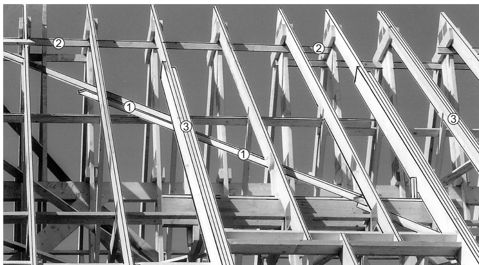
Vue C : Dispositif antiflambement
